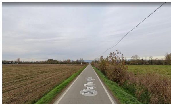
Prosecuzione pista ciclabile su lato sinistro
